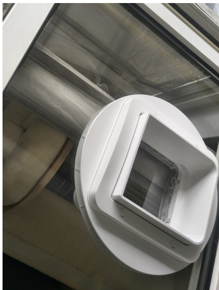
Fertige Katzenklappe in der Verglasung.
