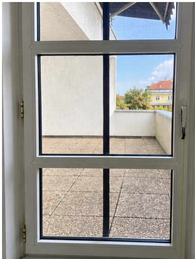
Verglasung vor dem Einbau - sauber dokumentiert.
