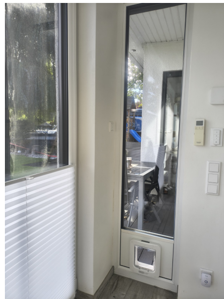
NACHHER: unten Sandwichplatte, oben weiterhin Glas.
