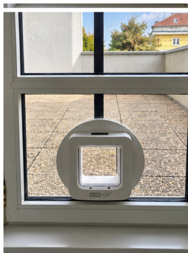
Fertiger Einbau in der Verglasung.
